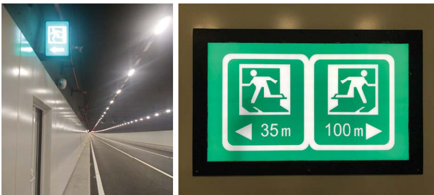
行车方向左侧隧道管壁逃生疏散标识
