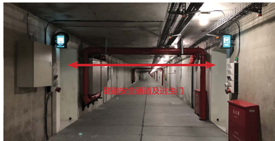
中央管廊逃生安全疏散通道及左右安全防火门
