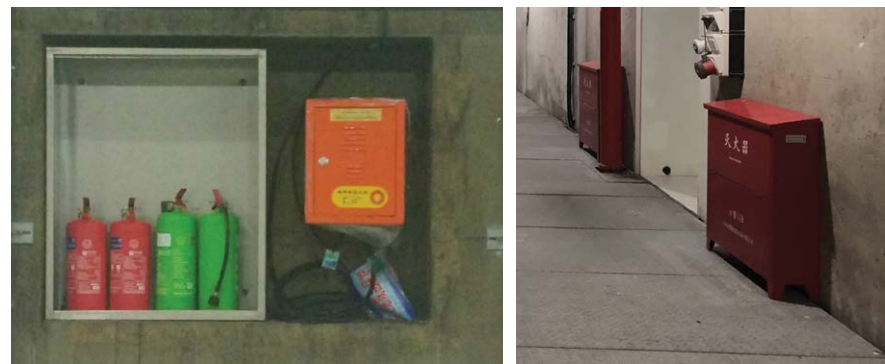
隧道行车孔灭火器箱
