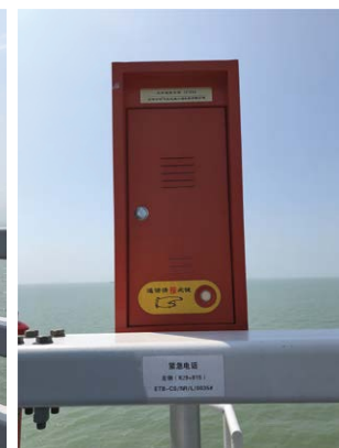
桥梁段紧急电话桩
